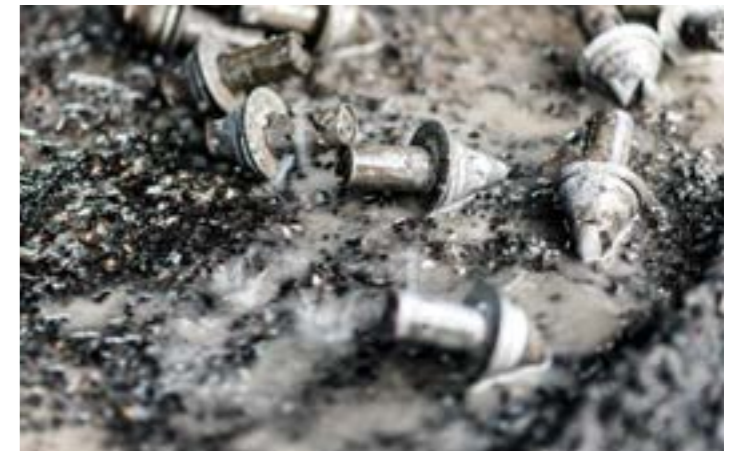
Aufgerieben im Dienste der Asphaltsanierung
